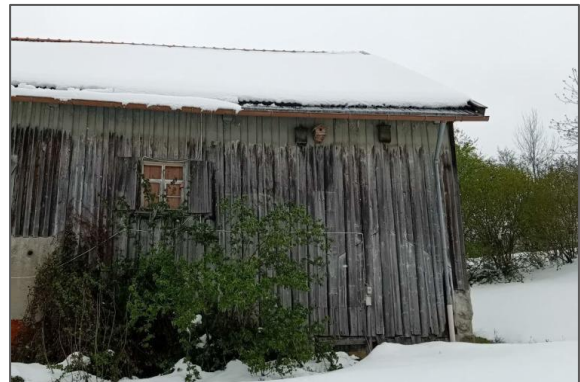
Abbildung 12: Blick auf die Südseite des Gebäudes mit Fledermauskästen und Vogelnistkasten
