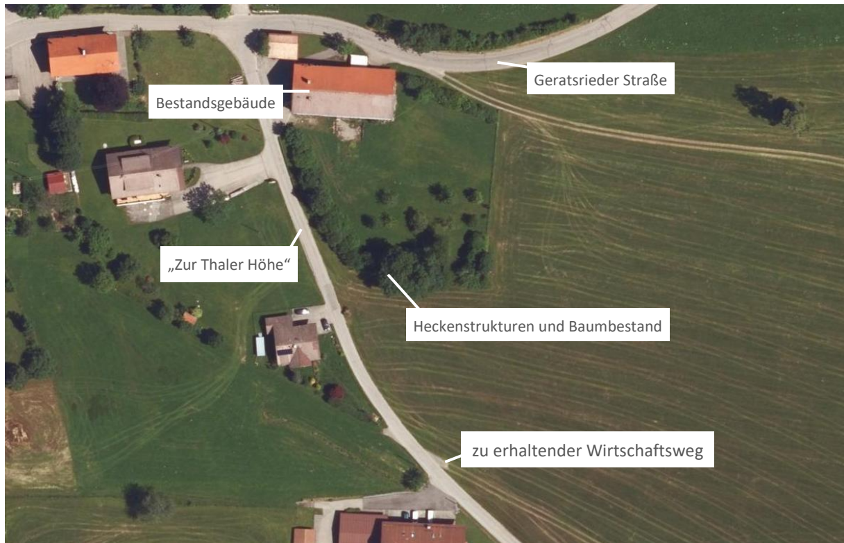
Abbildung 10: Ist-Zustand des Planbereichs im Osten von Wiederhofen (Quelle: BayernAtlas)
